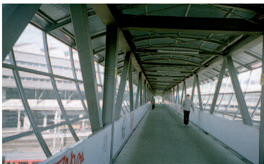
Überdachte Bereiche, punktueller Witterungsschutz.
