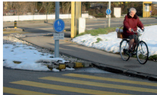
Vermeiden von Absätzen oder Stufen bei Veloverbindungen.
