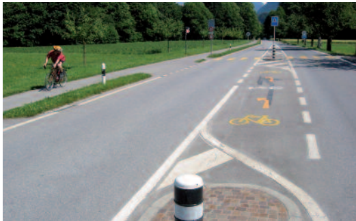
Geschützte Wartespur in der Fahrbahnmitte für linksabbiegende Velos.
