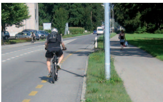
Übergänge von Fahrbahn auf separate Radwege und umgekehrt sicher und fahrradgerecht gestalten. Hier: Abgang von Fahrbahn-Radstreifen auf separierten Radweg velogerecht und sicher befahrbar ausgeführt.
