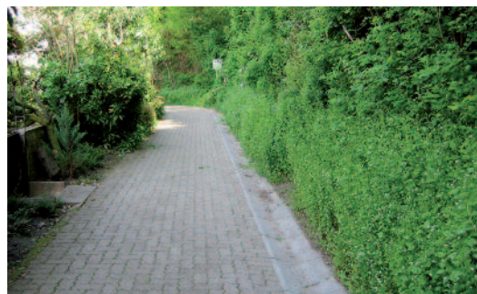
Fusswege im Grünen ohne Beleuchtung werden bei Nacht unbenutzbar.
