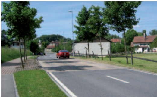
Trennstreifen zur Fahrbahn.
